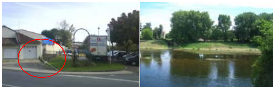
Busage du ruisseau du Veneyrol au niveau du parking de l'actuel supermarché et de sa confluence avec la Dordogne
