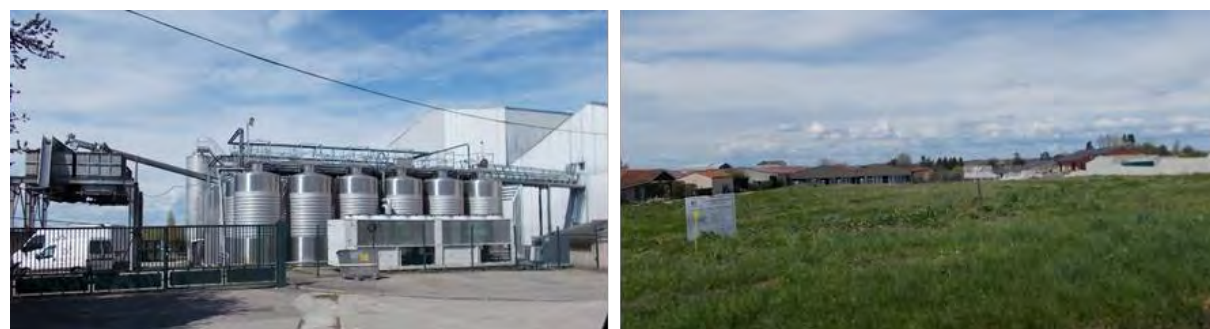
Vue de la cave coopérative de Landerrouat et de la zone d'activités
