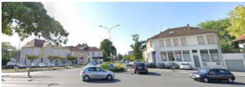
Entrée Sud : rue Victor Hugo
