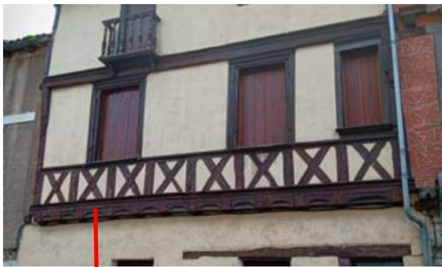
Détail des parédales fermant l'intervalle entre les solives au premier étage d'une maison au 29, rue des Frères Reclus - AB 499
