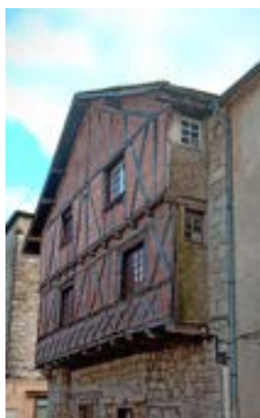
AB498 - étage pans de bois 23 rue de la République
