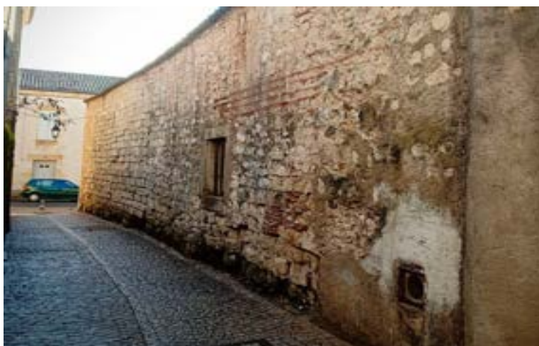
Portion de l'enceinte médiévale (parement côté ville) conservée le long de l'actuelle rue des Remparts). Les assises régulières en moellons équarris sont bien visibles après la fenêtre (la première partie du mur ainsi que les assises de briques n'appartiennent pas à l'enceinte médiévale).
