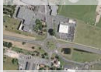
6/ infrastructures, équipements et commerces, artificialisation et banalisation
