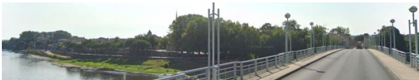
Paysage des berges et du franchissement de la Dordogne
