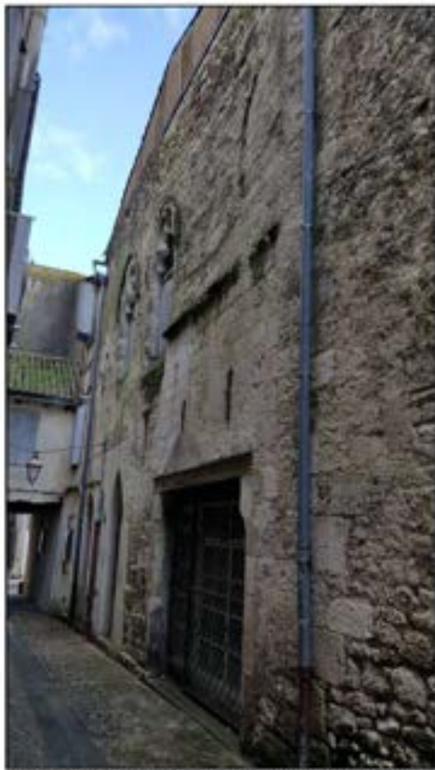
6- Vue d'ensemble de la façade nord le long du ruet Alphonse de Poitiers (cl. David Souny - 2019).
