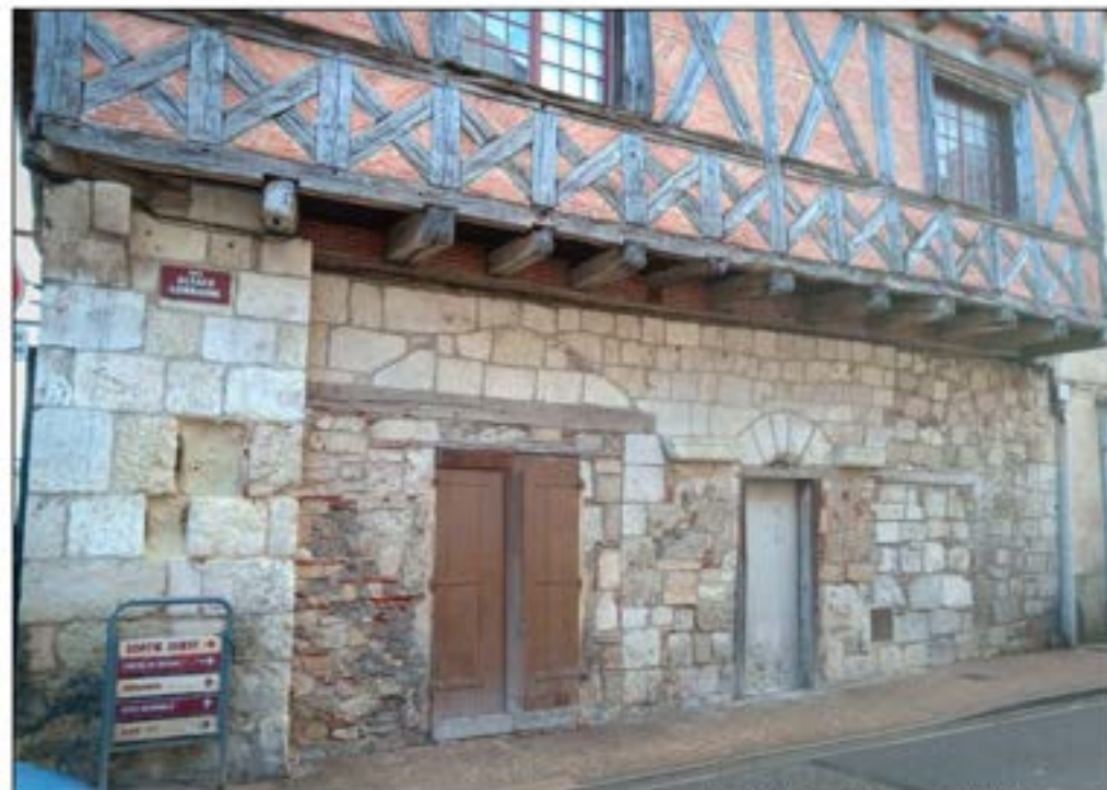
10a et 10b- Rez-de-chaussée de la façade nord et restitution des ouvertures primitives : arcade, porte et baie de boutique. (cl. Etienne Saliege - 2019. Infographie : David Souny).
