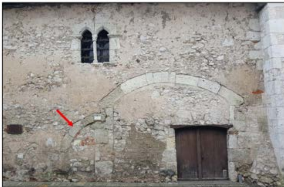
2- Détails des ouvertures sur la façade nord. Au rez-de-chaussée, une grande baie de boutique (ou un portail ?), couverte d'un arc surbaissé, est venue remplacer une porte plus ancienne en arc brisé dont subsiste une partie indiquée par la flèche rouge (cl. David Souny - 2019).
