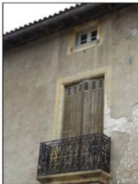
4- Grande croisée au 1 er étage de la façade nord (cl. Etienne Saliège - 2019).
