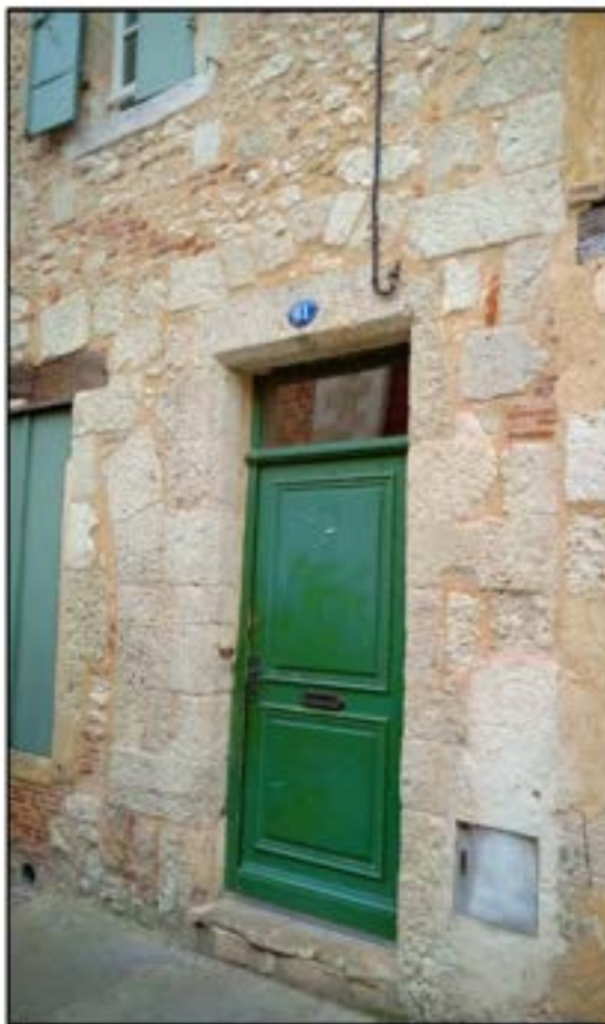
3- détail de l'extrémité occidentale de la façade avec la porte d'origine et le départ d'une 2 e ouverture de boutique (cl. David Souny - 2019).
