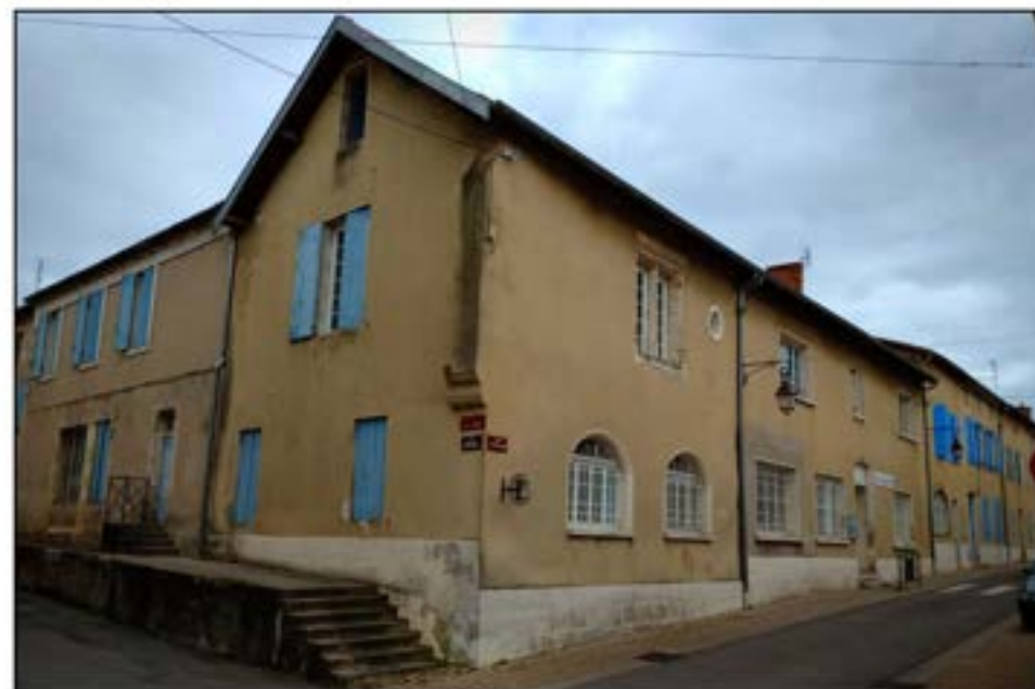
1- Vue d'ensemble des façades nord et ouest (cl. Etienne Saliege - 2019).
