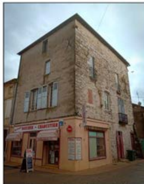
14- Façades nord et ouest (cl. Etienne Salège)
