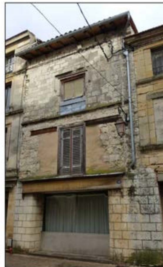
1- Vue d'ensemble de la façade sur la rue Victor Hugo (cl. David Souny - 2019).
