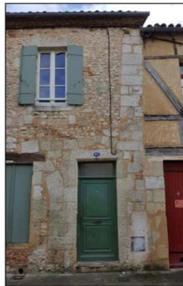
4- Vue de la moitié occidentale de la façade avec la porte d'origine et l'ancienne tête de mur formant l'extrémité de l'étage, signe de l'existence primitive d'une façade à pan-de-bois (cl. David Souny - 2019)
