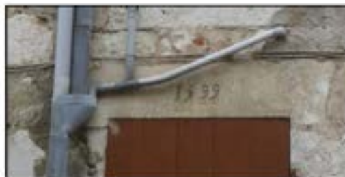
5- Détail du linteau de la fenêtre du rez-de-chaussée portant la date « 1599 » (cl. Etienne Saliège - 2019).
