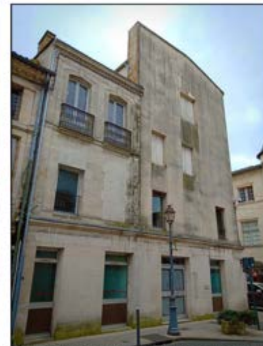
5- Vue de la façade nord (rue de la République) avec son mur écran masquant la toiture (cl. Etienne Saliege - 2019).
