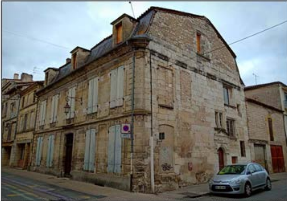
1- Vue d'ensemble des façades ouest (sur la rue Victor Hugo) et sud (rue Alsace Lorraine) (cl. Etienne Saliege – 2019).
