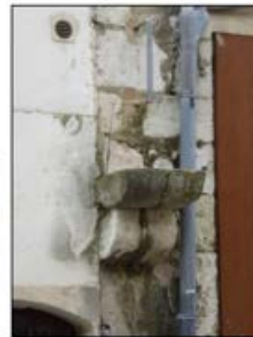
6- Encorbellement à l'extrémité de la façade est qui devait servir de support pour la façade à pan-de-bois (disparu) de la maison voisine (cl. Etienne Saliège - 2019).
