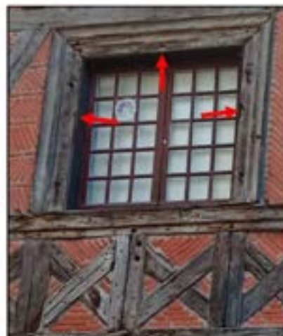
7- Détail de la croisée de la façade est dont l'encadrement mouluré porte encore les encoches du meneau et de la traverse. (cl. Etienne Saliege - 2019).
