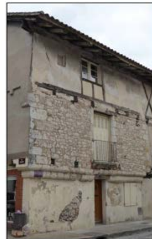
2- Vue d'ensemble de la façade ouest (cl. Etienne Salège - 2019).
