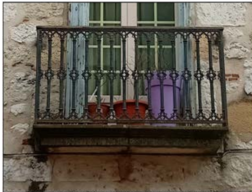
19- Détail du garde-corps en fonte au décor néogothique sur la porte-fenêtre à l'étage de la façade ouest (cl. Etienne Saliege).
