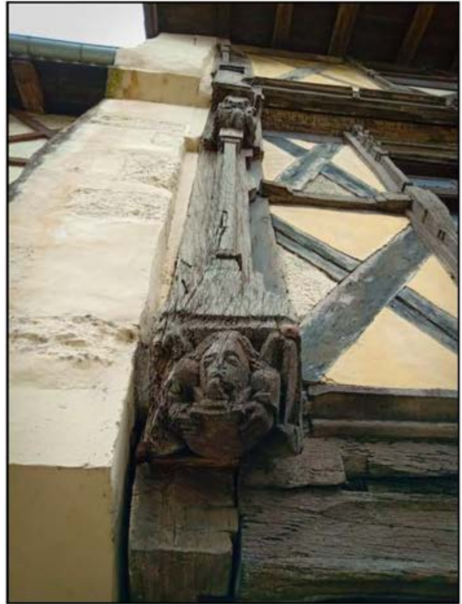
11- Décor sculpté sur le poteau accolé à la tête de mur saillante du gouttereau ouest (cl. Etienne Saliège - 2019).
