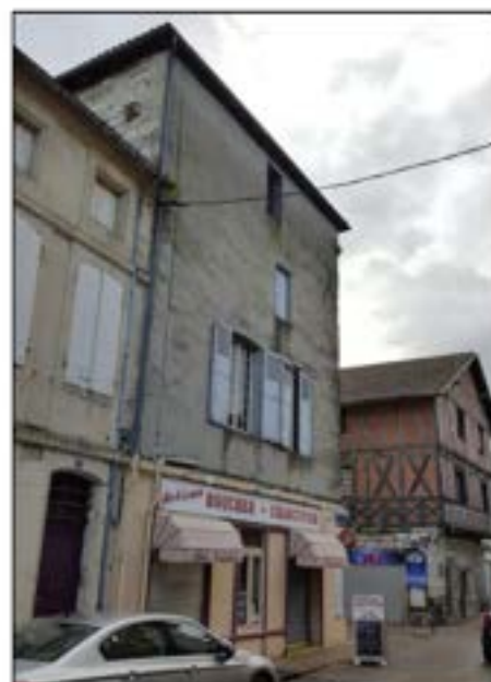
16- Sommet de la façade est et façade nord et (cl. David Soumy)
