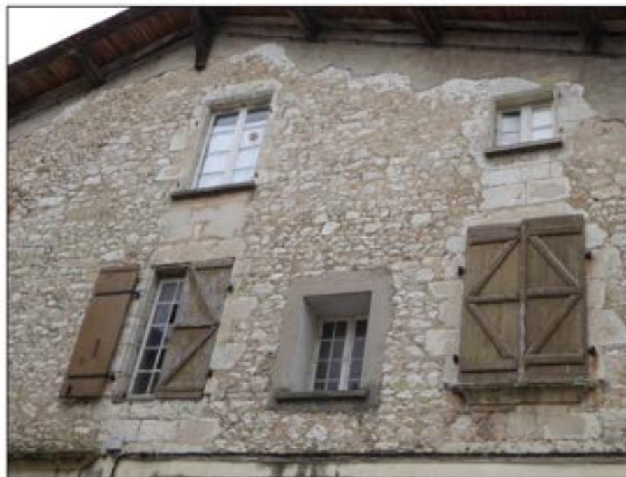
7- Fenêtres de la façade nord dont seule celle en bas à droite a conservé son appui d'origine. Les encadrements chanfreinés d'origine des baies du 1 er étage ont été retaillés pour ménager les feuillures des volets (cl. Etienne Saliège - 2019).
