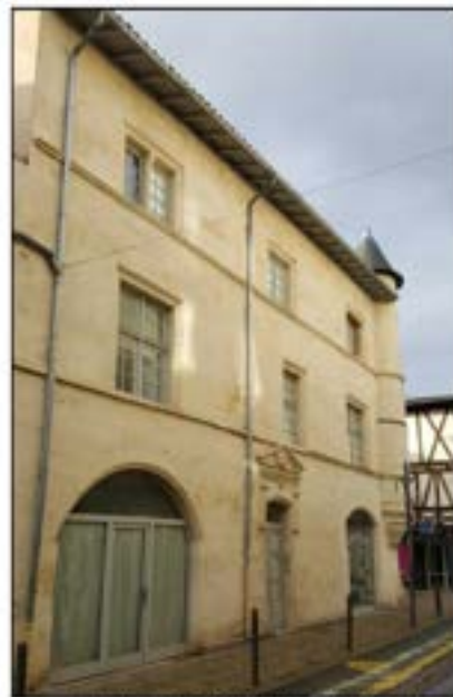
14- Vue de la façade est (rue Victor Hugo) (cl. David Souny - 2019).
