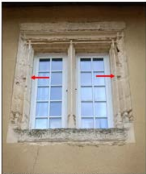
2- Détail de la grande croisée à l'étage du mur ouest. La traverse disparue se trouvait au niveau des flèches rouges (cl. Etienne Saliège - 2019).
