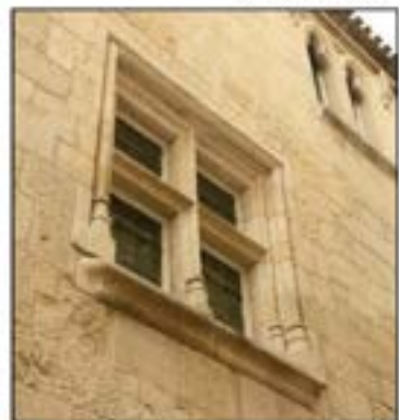
4- Exemple d'une grande croisée du même type (sans bandeau larmier) sur une maison de Saint-Émilion (cl. A Marin 2012).
