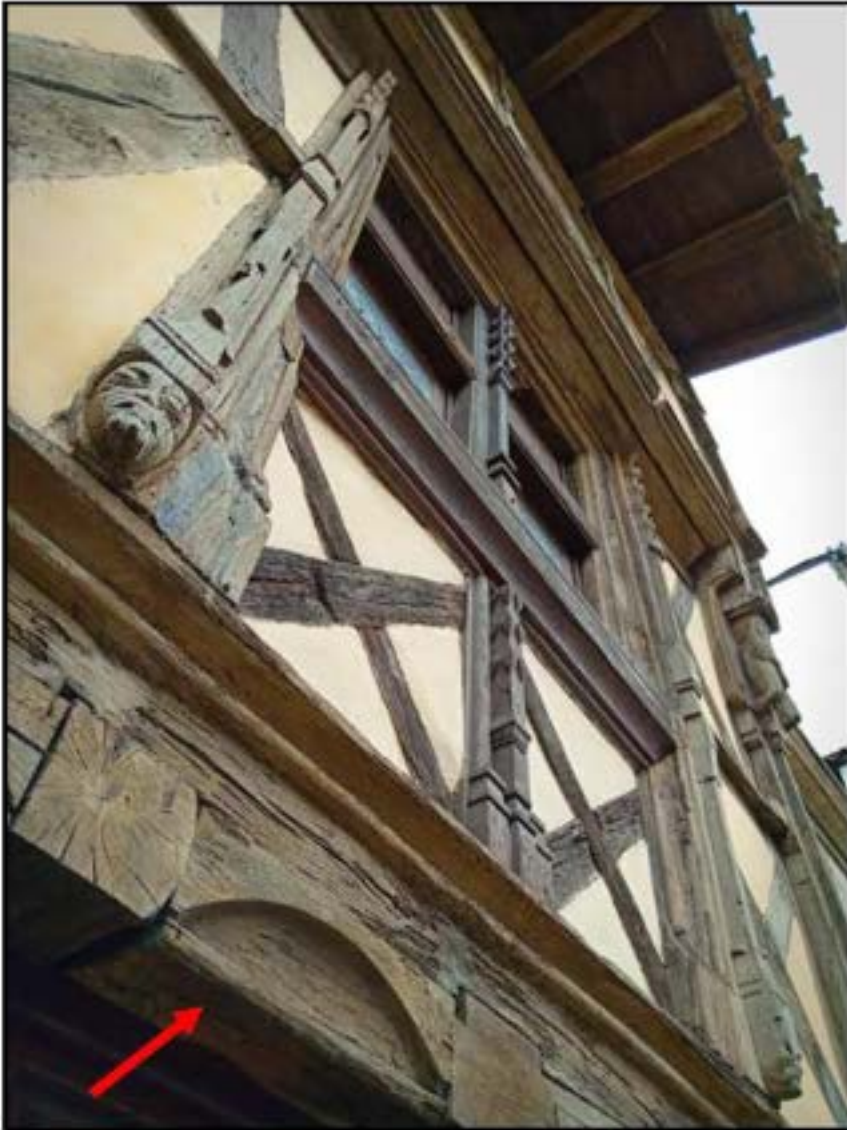
12- Détail du décor sculpté du 1 er étage. La flèche rouge indique un closoir venant combler l'entrevous (espace entre les deux solives). (cl. Etienne Saliège - 2019).
