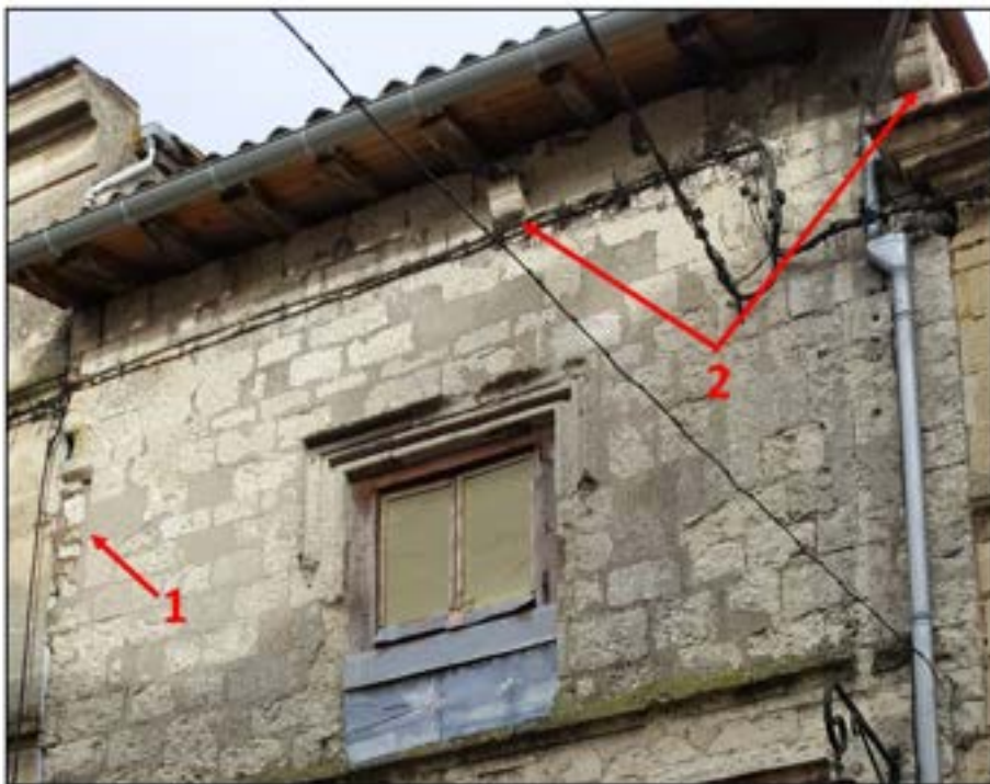
2- Détail de la partie supérieure de la façade. En 1: départ d'une petite fenêtre chanfreinée et arrachement du mur de façade qui se prolongeait initialement sur la parcelle voisine. En 2, deux corbeaux en quart-de-rond sur lesquels était fixé un auvent qui protégeait les fenêtres du 2 e étage (cl. D. Souny – 2019).
