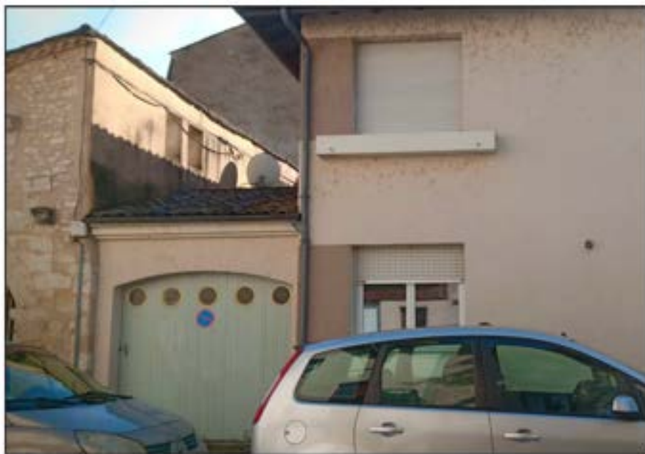
10- Vue de la façade arrière (façade ouest) (cl. Etienne Saliège – 2019).
