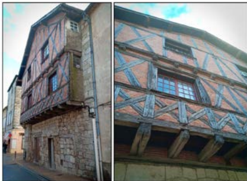
8 et 9- Vue d'ensemble de la façade est et détail des encorbellements (cl. Etienne Saliege - 2019).
