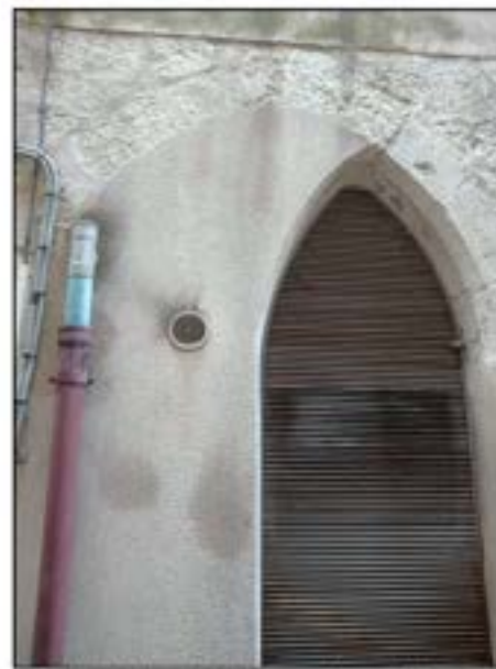
9- Détail de l'une des deux grandes arcades du rez-de-chaussée partiellement murée (cl. Etienne Salège - 2019).
