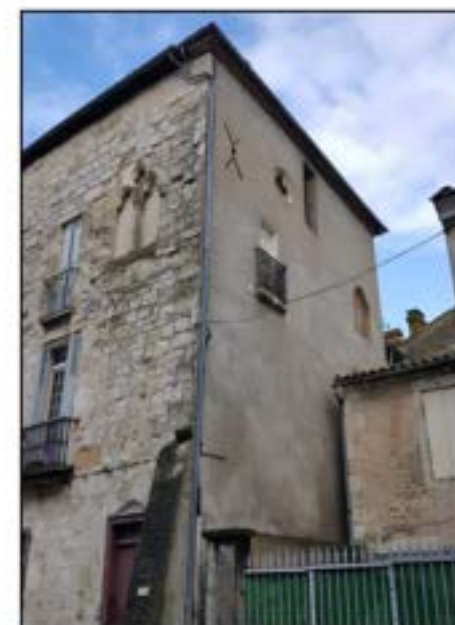
17- Façades ouest et sud (cl. David Soumy)
