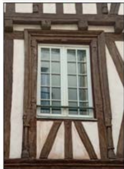
10 et 11- Vue d'ensemble et détail d'une fenêtre de la 4 e travée sur la façade est. Si la moulure périphérique présente un registre très proche de la fenêtre précédente, l'encadrement est ici chanfreiné et s'interrompt au niveau de la jonction de la traverse et du meneau dont le profil devait être similaire à ceux des fenêtres du 2 e étage (voir fig. 12 pour restitution). (cl. Etienne Saliege - 2019).
