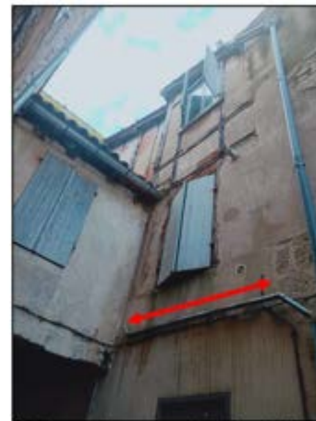
10- Annexe « récente » construite sur l'emprise d'une ancienne venelle (délimitée par la double flèche rouge) bordant le côté oriental de la maison (cl. Etienne Salège - 2019).
