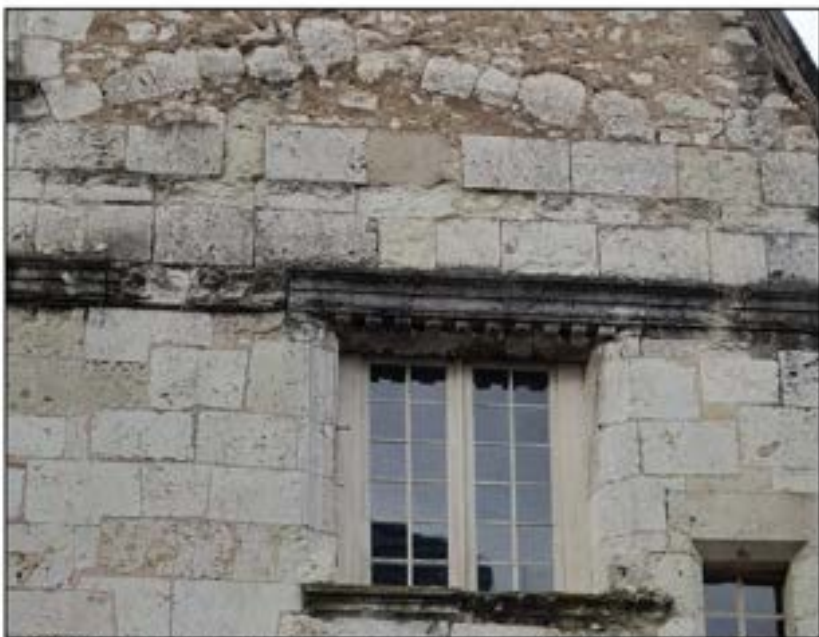
7- Détail de la fenêtre haute de l'escalier avec son linteau orné de gouttes sur sa face inférieure. Ce linteau s'inscrit dans la continuité de la corniche (dont il reprend le registre décoratif) qui délimite le comble (cl. David Souny – 2019).
