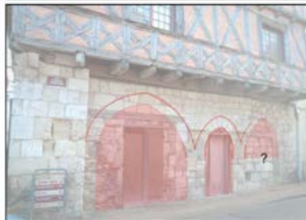
10a et 10b- Rez-de-chaussée de la façade nord et restitution des ouvertures primitives : arcade, porte et baie de boutique. (cl. Etienne Saliege - 2019. Infographie : David Souny).
