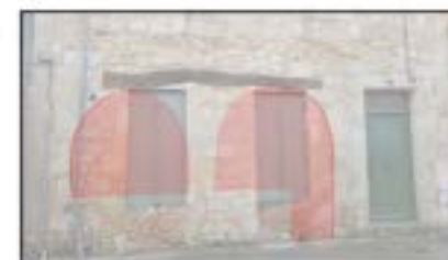
1a- Vue d'ensemble de la façade nord dont le rez-de-chaussée était à l'origine percé de deux ouvertures de boutique et d'une porte (cl. David Souny - 2019).
