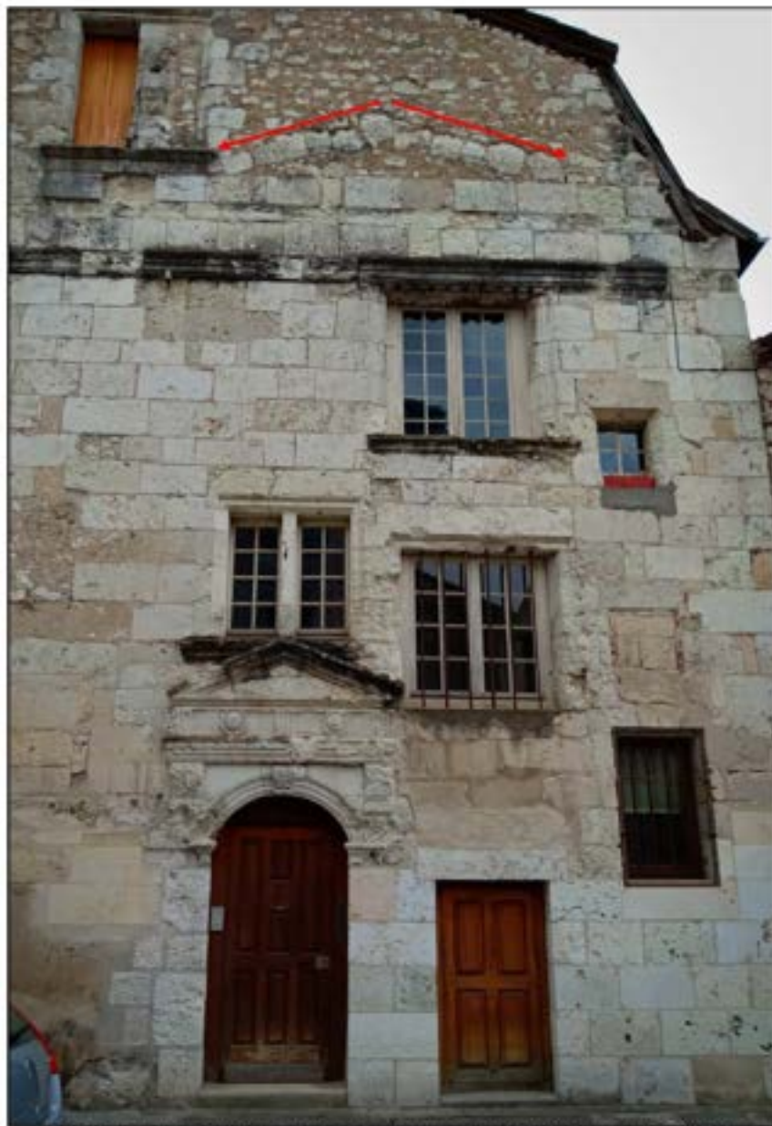
4- Détail de la partie orientale du pignon sud ayant conservé son état Renaissance. Ces différentes ouvertures correspondent certainement à une cage d'escalier couverte d'une voûte dont la tranche, visible en façade (flèches rouges) indique un profil très tendu (cl. Etienne Saliege – 2019).
