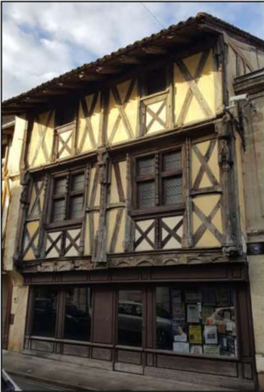
10- Vue d'ensemble de la façade sud (cl. David Souny - 2019).
