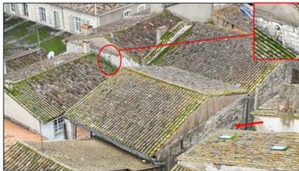
11- Vue de la toiture de la maison ruet Alphonse de Poitiers prise depuis le clocher de l'église. La façade visible sur la photo 6 est indiquée par la flèche rouge. On notera à l'arrière de cette maison, sur le mur latéral d'une maison donnant sur la rue Alsace-Lorraine (n°26), la présence d'une petite fenêtre gothique à lancette, entourée en rouge ici (cl. David Souny - 2019).
