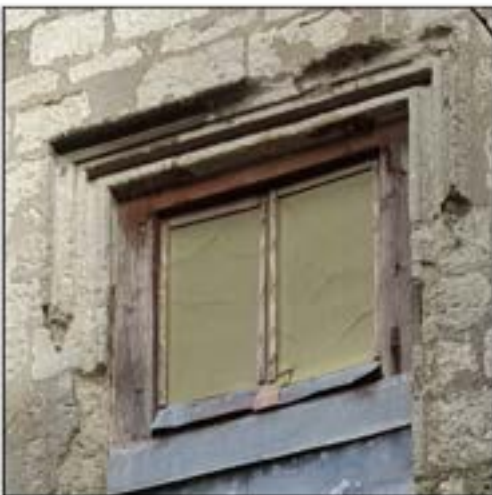
3- Détail de la fenêtre du 2 e étage (cl. David Souny – 2019).
