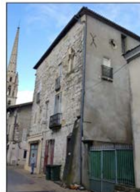
15- Façades ouest et sud (cl. David Soumy)
