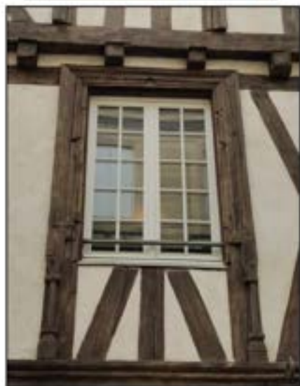
8 et 9- Vue d'ensemble et détail d'une fenêtre de la 2 e travée sur la façade est. L'emplacement de la traverse et du meneau qui venaient s'encastrent dans la moulure périphérique est bien visible (voir fig. 12 pour proposition de restitution). On retrouve le même encadrement (à l'exception des deux colonnettes qui encadrent ici l'allège) sur la première travée ainsi que sur la façade sud (cl. David Sourry - 2019).
