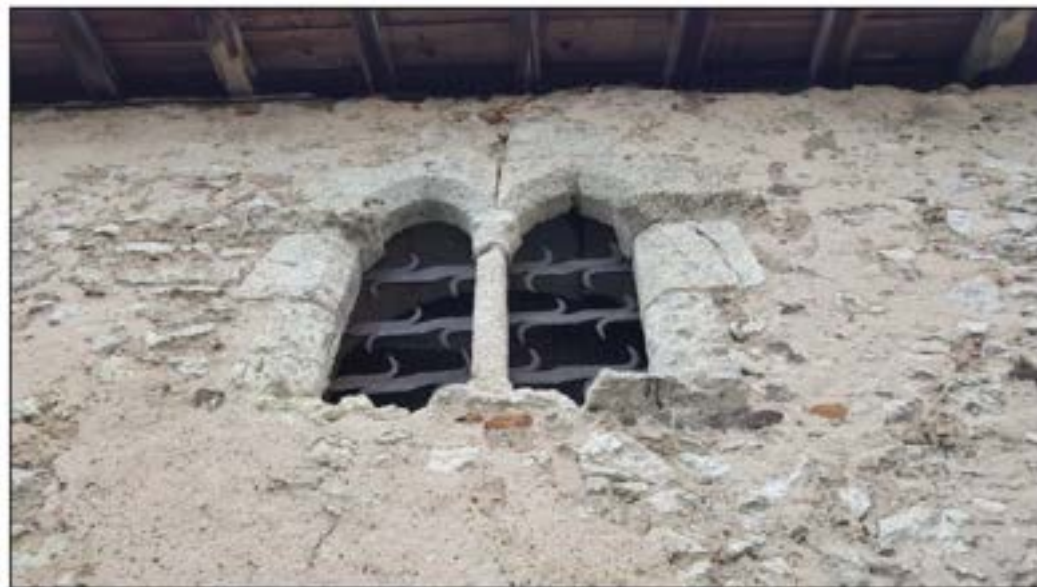
3- Détail de la fenêtre géminée de l'étage (cl. David Souny - 2019).
