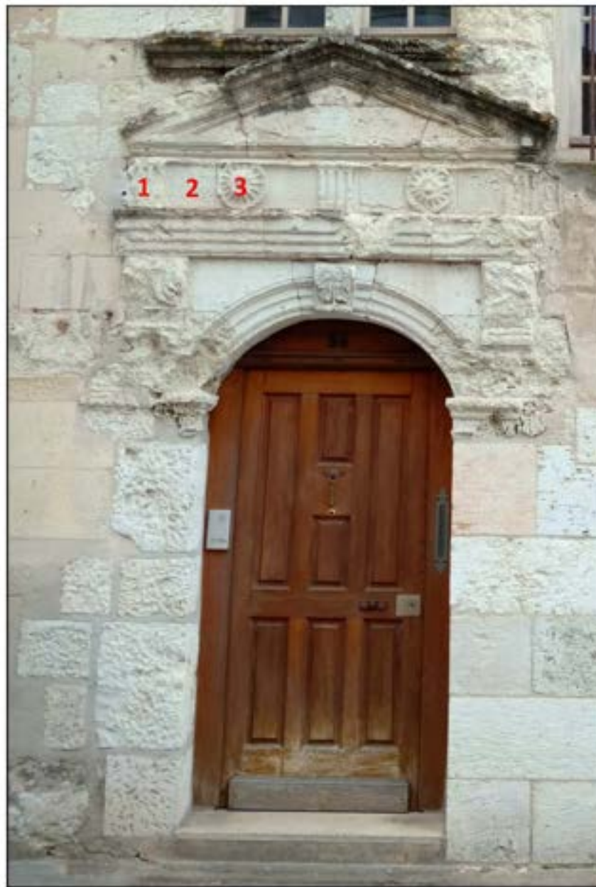
5- Détail de la porte Renaissance. L'entablement qui porte le fronton triangulaire est orné d'une frise alternant des triglyphes (n°1), des métopes (2) et des patères florales (3) (cl. Etienne Saliege – 2019).
