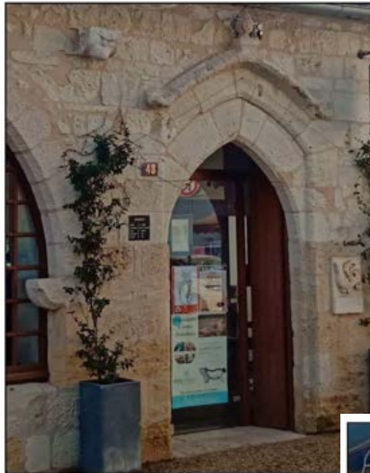
7- Détail de la porte sur la façade est (cl. Etienne Saliège – 2019).
