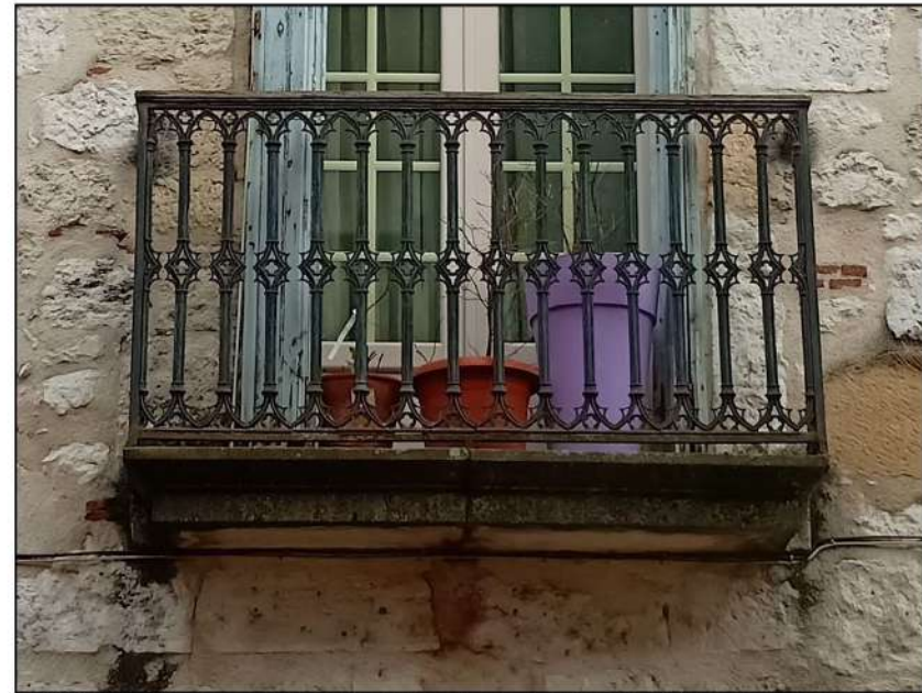
19- Détail du garde-corps en fonte au décor néogothique sur la porte-fenêtre à l'étage de la façade ouest (cl. Etienne Saliège).
