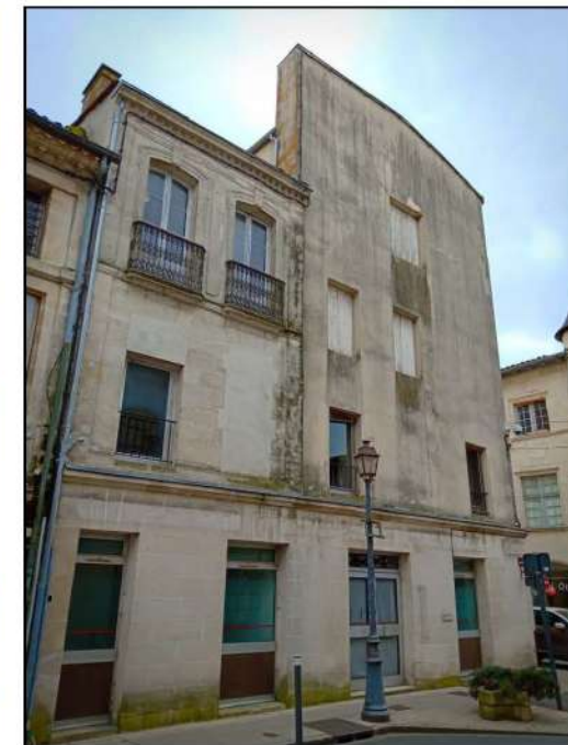
5- Vue de la façade nord (rue de la République) avec son mur écran masquant la toiture (cl. Etienne Saliège - 2019).
