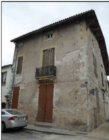
1- Vue d'ensemble de la façade est (cl. Etienne Saliège - 2019).
