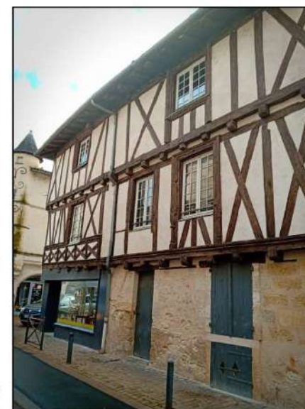
7- Vue de la façade est, rue Victor Hugo (cl. David Souny - 2019).
