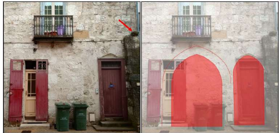
20- Vestiges des ouvertures primitives (grande arcade boutique et porte) au rez-de-chaussée de la façade ouest. Le corbeau (indiqué par la flèche rouge) pourrait correspondre à un support pour un auvent qui devait protéger les ouvertures du rez-de-chaussée (cliché et infographie David Souny).
