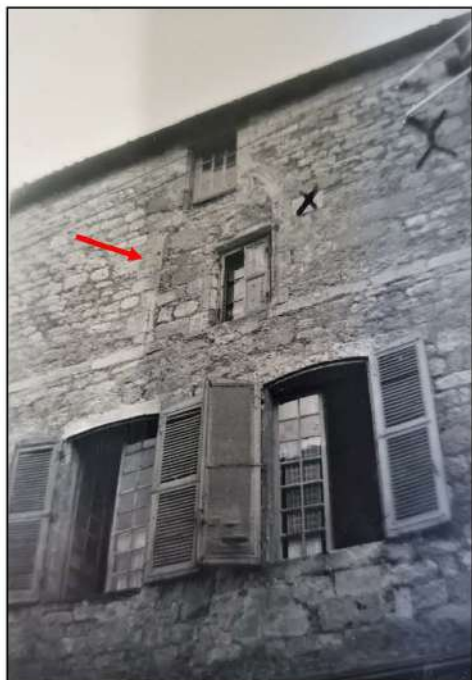
12 et 13- Photos de la maison en 1953, avant travaux. À gauche, on repère une grande baie à réseau gothique (indiquée par la flèche rouge) aujourd'hui masquée sous l'enduit en ciment qui recouvre la façade nord (rapport de classement, MAP).
