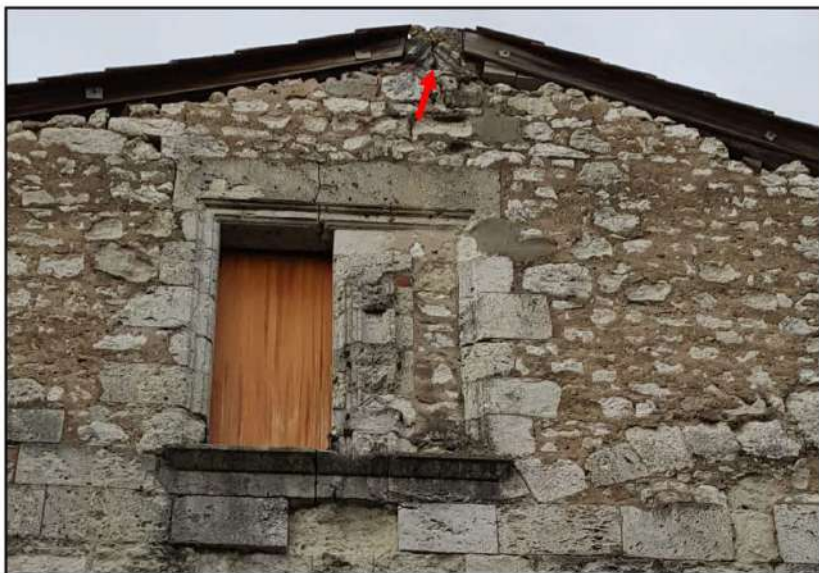
6- Détail de la fenêtre du pignon sud partiellement murée. Son imposant meneau a été légèrement déporté sur la droite lorsque cette partie a été condamnée. La flèche rouge indique deux éléments de corniche en remploi appartenant peut-être à l'ancien rampant du pignon (cl. David Souny – 2019).
