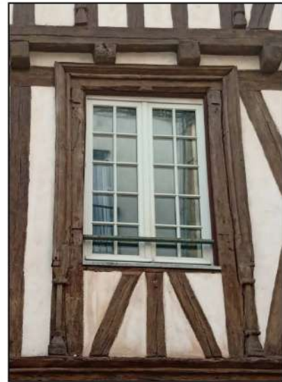
10 et 11- Vue d'ensemble et détail d'une fenêtre de la 4 e travée sur la façade est. Si la moulure périphérique présente un registre très proche de la fenêtre précédente, l'encadrement est ici chanfreiné et s'interrompt au niveau de la jonction de la traverse et du meneau dont le profil devait être similaire à ceux des fenêtres du 2 e étage (voir fig. 12 pour restitution). (cl. Etienne Saliège - 2019).
