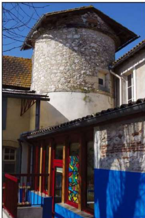
3- Vue du pignon nord (rue Denfert Rochereau). La tête de mur en saillie sur la droite indique que cette façade était à l'origine à pan-de-bois (cl. Etienne Saliège - 2019).
