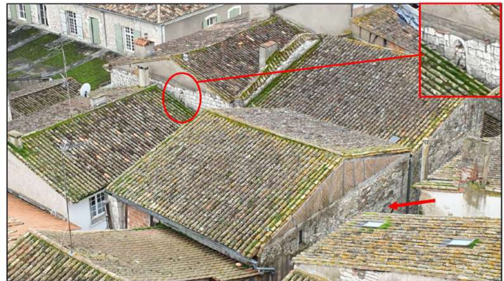
11- Vue de la toiture de la maison ruet Alphonse de Poitiers prise depuis le clocher de l'église. La façade visible sur la photo 6 est indiquée par la flèche rouge. On notera à l'arrière de cette maison, sur le mur latéral d'une maison donnant sur la rue Alsace-Lorraine (n°26), la présence d'une petite fenêtre gothique à lancette, entourée en rouge ici (cl. David Souny - 2019).
