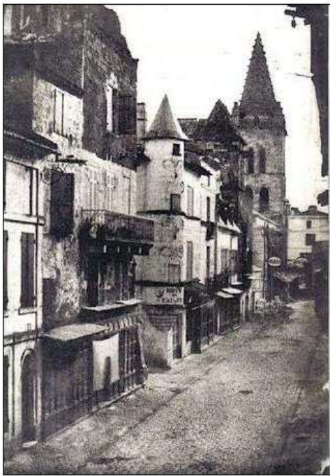
6- Photographie de la rue de la République avant la reconstruction du clocher et l'agrandissement de l'église, donc avant 1869 (©Amis de Sainte-Foy et de sa région).
