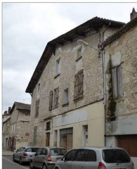
2- Vue d'ensemble de la façade nord (cl. Etienne Saliège - 2019).
