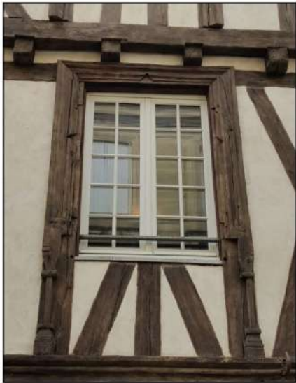
8 et 9- Vue d'ensemble et détail d'une fenêtre de la 2 e travée sur la façade est. L'emplacement de la traverse et du meneau qui venaient s'encaster dans la moulure périphérique est bien visible (voir fig. 12 pour proposition de restitution). On retrouve le même encadrement (à l'exception des deux colonnettes qui encadrent ici l'allège) sur la première travée ainsi que sur la façade sud (cl. David Souny - 2019).
