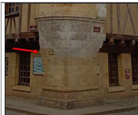
6- Base de la tourelle d'angle conservant à gauche, le départ d'une arcade (flèche rouge) ; et à droite, des arrachements de maçonnerie qui semblent indiquer que l'on prévoyait initialement une construction entièrement en pierre (cl. Etienne Saliège - 2019).
