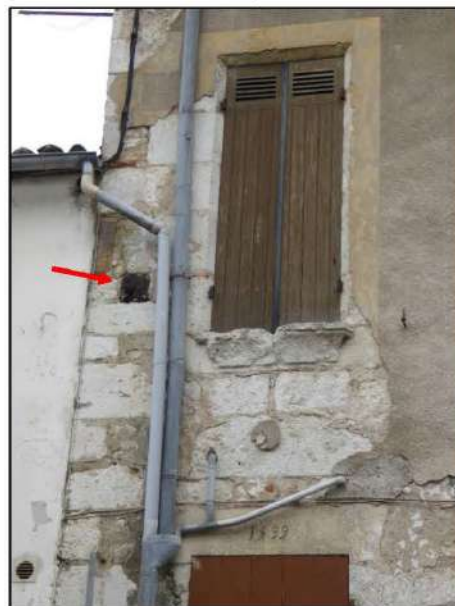
3- Demi-croisée au 1 er étage de la façade est et date portée « 1599 » sur le linteau de la fenêtre du rez-de-chaussée. La flèche rouge indique une pièce de bois recoupée au nu du mur (cl. Etienne Saliège - 2019).
