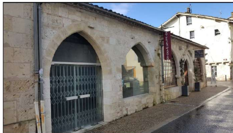
4- Vue d'ensemble de la façade est le long de la rue Pasteur (cl. David Souny - 2019).
