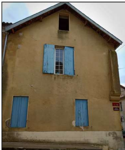
3- Vue du pignon nord (rue Denfert Rochereau). La tête de mur en saillie sur la droite indique que cette façade était à l'origine à pan-de-bois (cl. Etienne Saliège - 2019).
