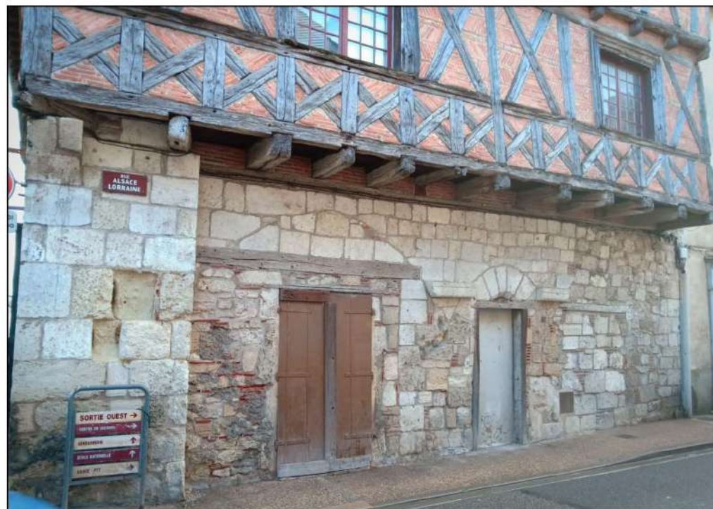
10a et 10b- Rez-de-chaussée de la façade nord et restitution des ouvertures primitives : arcade, porte et baie de boutique. (cl. Etienne Saliège - 2019. Infographie : David Souny).
