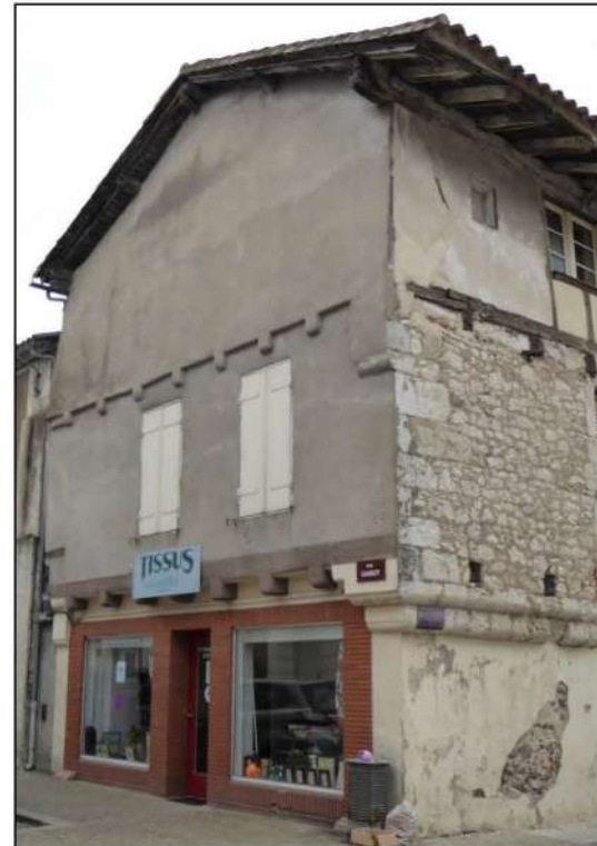
1- Vue d'ensemble de la façade nord (cl. Etienne Saliège - 2019).
