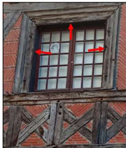
7- Détail de la croisée de la façade est dont l'encadrement mouluré porte encore les encoches du meneau et de la traverse. (cl. Etienne Saliège - 2019).
