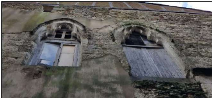
8- Détail des fenêtres de l'étage (cl. David Souny - 2019).
