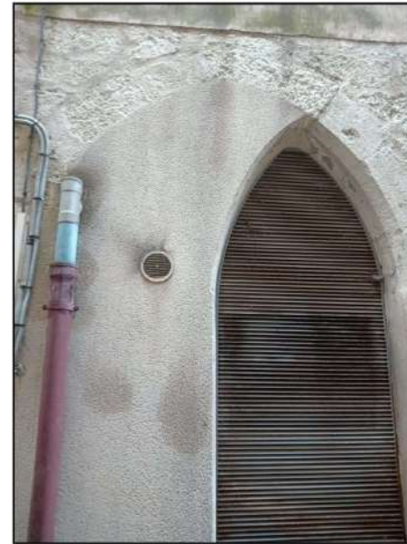
9- Détail de l'une des deux grandes arcades du rez-de-chaussée partiellement murée (cl. Etienne Saliège - 2019).
