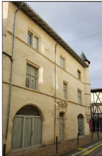
14- Vue de la façade est (rue Victor Hugo) (cl. David Souny - 2019).
