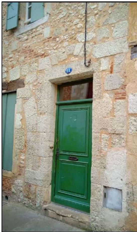
3- détail de l'extrémité occidentale de la façade avec la porte d'origine et le départ d'une 2 e ouverture de boutique (cl. David Souny - 2019).
