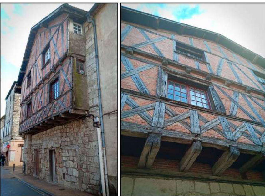
8 et 9- Vue d'ensemble de la façade est et détail des encorbellements (cl. Etienne Saliège - 2019).
