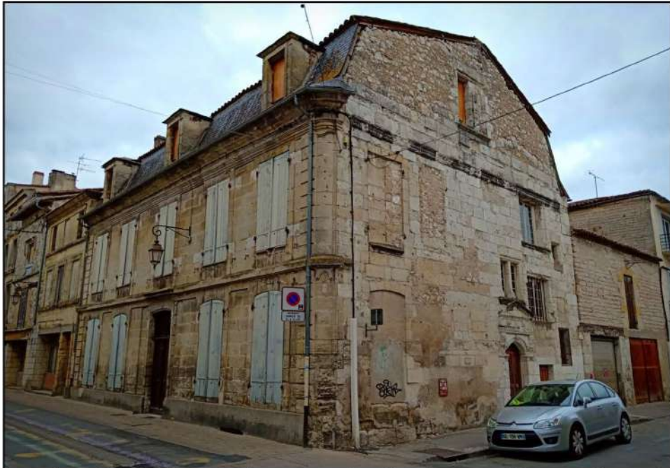
1- Vue d'ensemble des façades ouest (sur la rue Victor Hugo) et sud (rue Alsace Lorraine) (cl. Etienne Saliège – 2019).
