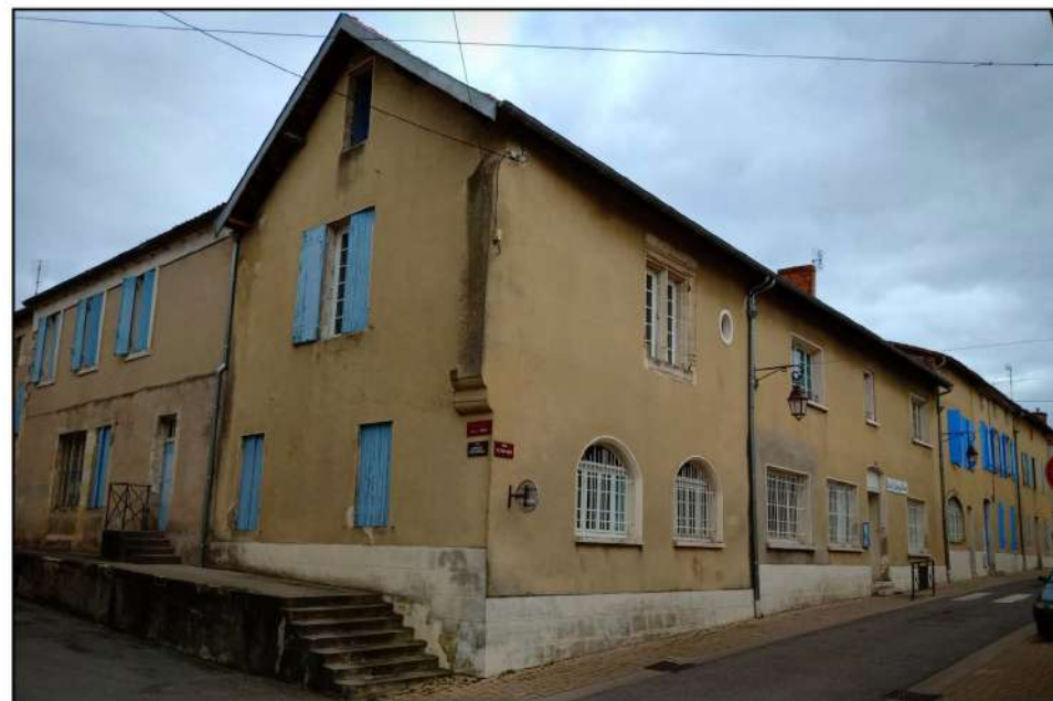
1- Vue d'ensemble des façades nord et ouest (cl. Etienne Saliège - 2019).
