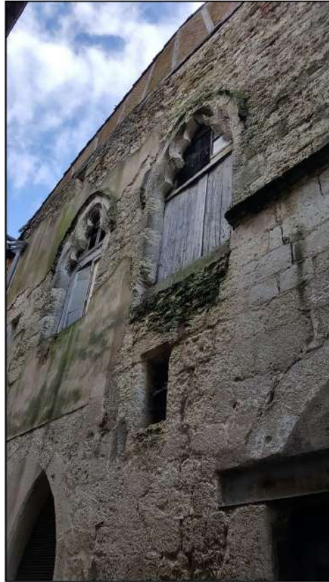
7- Détail des fenêtres de l'étage (cl. David Souny - 2019).
