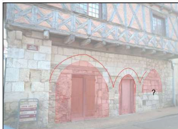
10a et 10b- Rez-de-chaussée de la façade nord et restitution des ouvertures primitives : arcade, porte et baie de boutique. (cl. Etienne Saliège - 2019. Infographie : David Souny).
