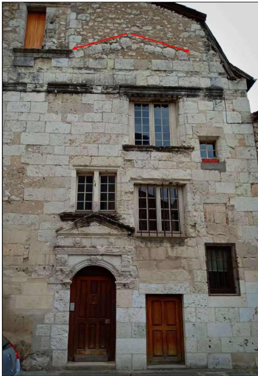
4- Détail de la partie orientale du pignon sud ayant conservé son état Renaissance. Ces différentes ouvertures correspondent certainement à une cage d'escalier couverte d'une voûte dont la tranche, visible en façade (flèches rouges) indique un profil très tendu (cl. Etienne Saliège – 2019).
