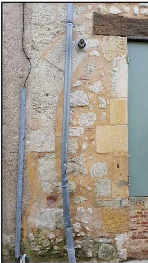
2- détail du départ de l'ancienne ouverture de boutique à l'extrémité orientale de la façade (cl. David Souny - 2019).
