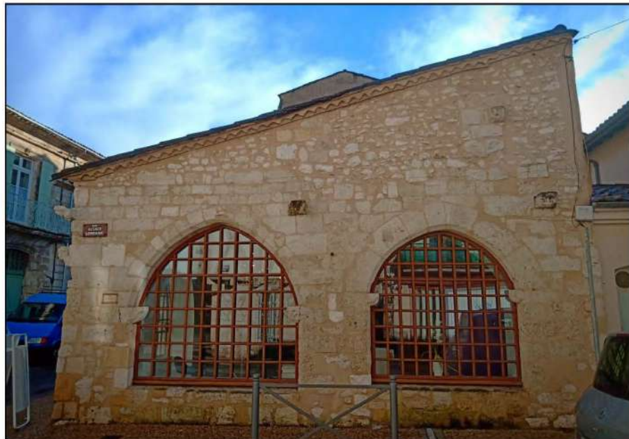
9- Vue d'ensemble de la façade nord (cl. Etienne Saliège – 2019).
