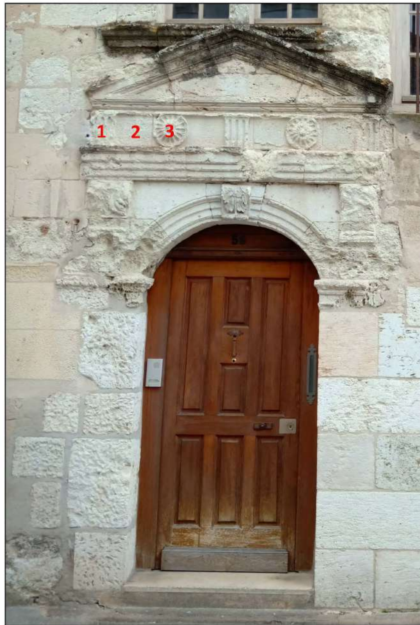
5- Détail de la porte Renaissance. L'entablement qui porte le fronton triangulaire est orné d'une frise alternant des triglyphes (n°1), des métopes (2) et des patères florales (3) (cl. Etienne Saliège – 2019).
