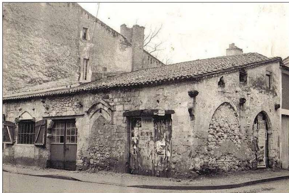
1- Vue d'ensemble de la maison avant sa restauration en 1953 (cl. Amls de Sainte-Foy).
