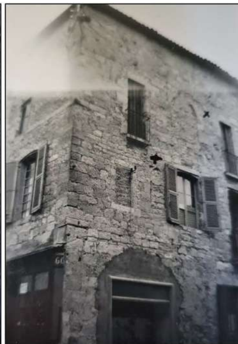
12 et 13- Photos de la maison en 1953, avant travaux. À gauche, on repère une grande baie à réseau gothique (indiquée par la flèche rouge) aujourd'hui masquée sous l'enduit en ciment qui recouvre la façade nord (rapport de classement, MAP).
